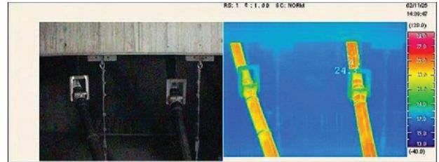
図 25 電力ケーブルの通電状態の確認
