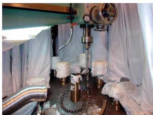
図2 管台引抜作業の様子
